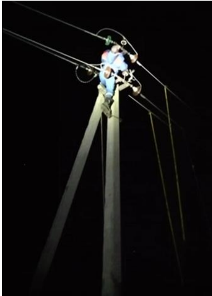
Опора № 37 ВЛ 10 кВ 1004 от ПС Черкутино
